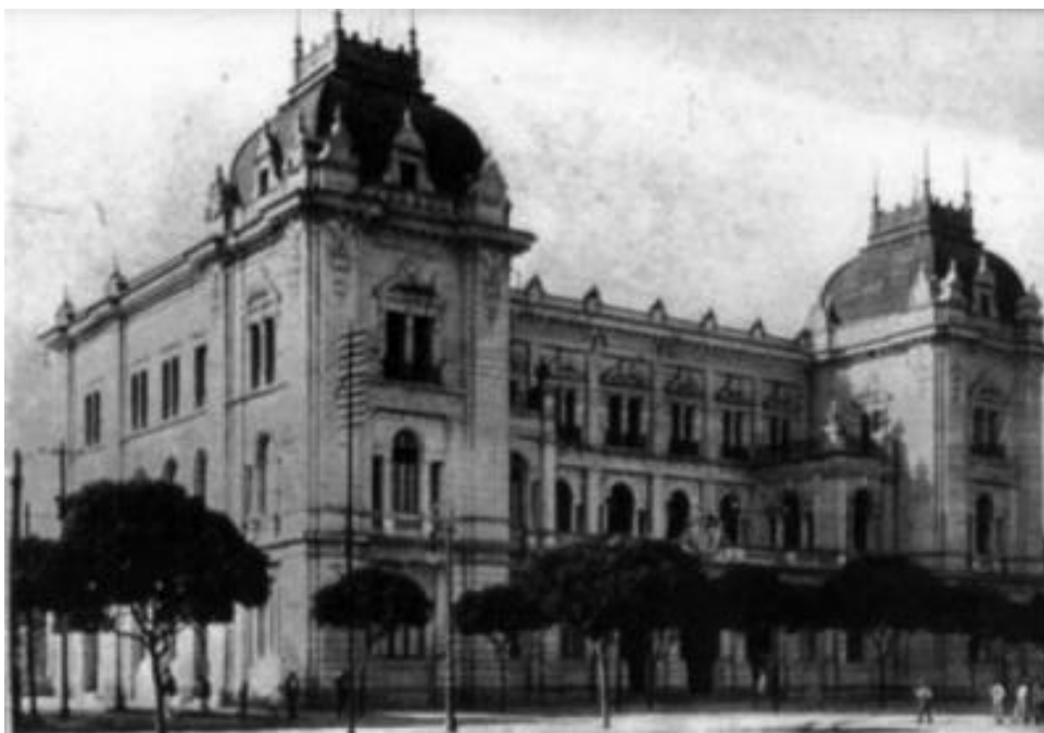
Figura 3 - Detalhe do prédio dos Correios, 1914, Álbum de Niterói, 1925.
