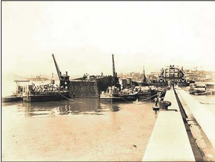
*Imagem 4: Enchimento de um caixão com concreto (caixão de 8 m. de altura) (APERJ)*
