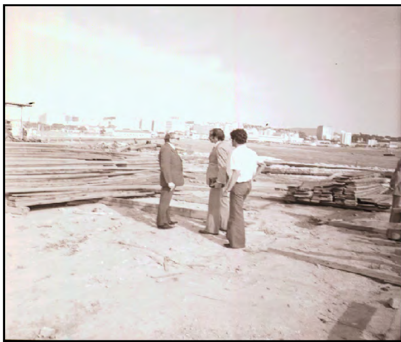
Figura 2: Obras da ponte Rio - Niterói. [RJ], 10 jan 1972. Fotógrafo: Milton.
