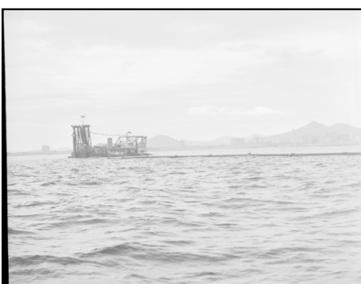
Imagem 12: Governador Raymundo Padilha inspeciona obras na orla marítima. 15 mar 1973.
